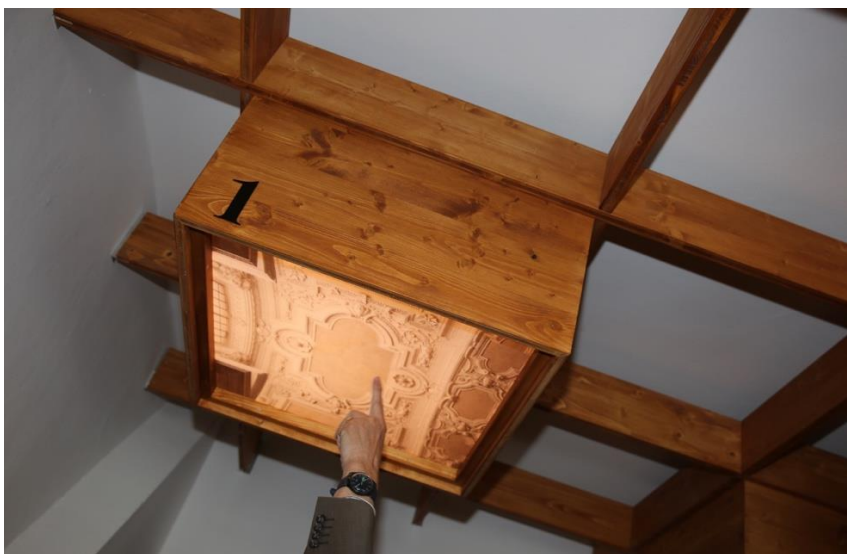
Uno dei cassettoni appesi al soffitto nella sala riservata ai lavori degli stuccatori
